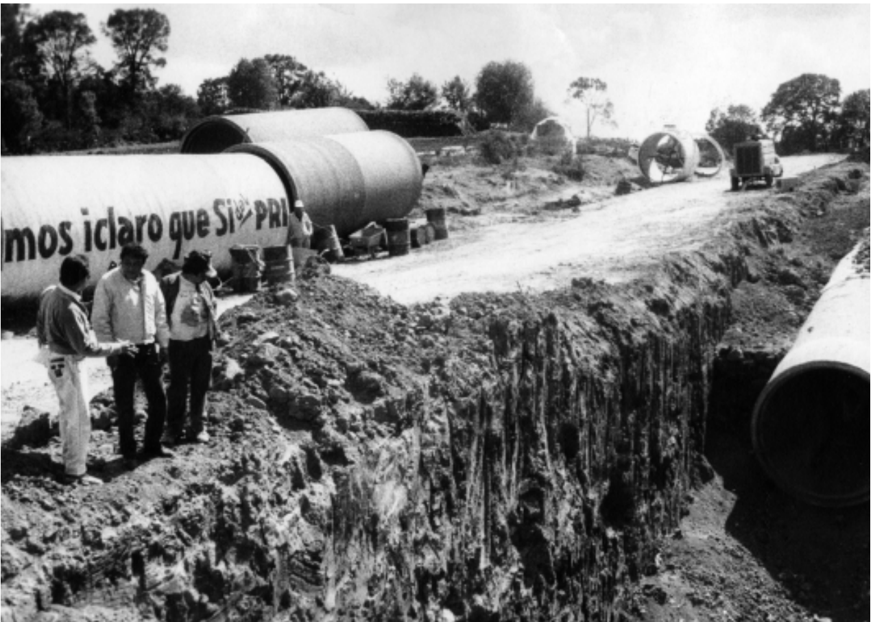
Imagen 79: Construcción del Sistema Cutzamala, en el municipio de Villa Victoria, Estado de México.
