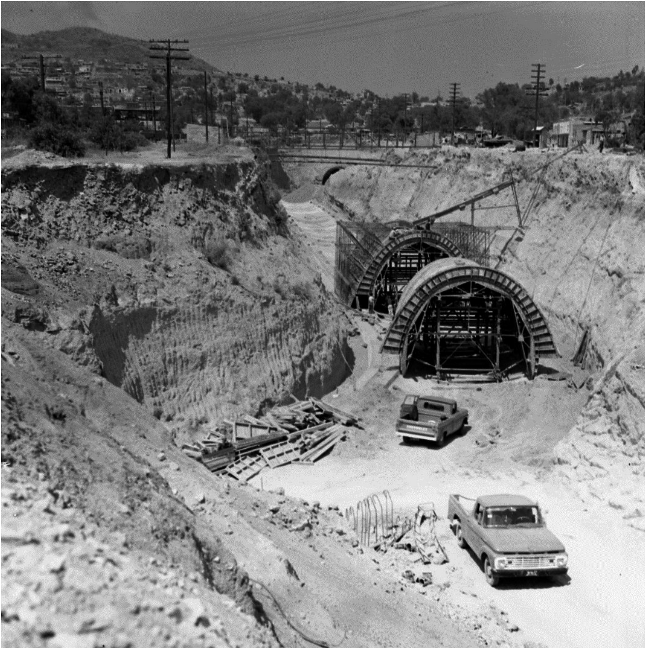
Imagen 77: Construcción del drenaje profundo. Fundación ICA (s.f.).
