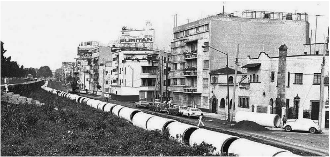
Imagen 78: Las obras del Circuito Interior en la Calzada Melchor Ocampo, a la altura del cruce con Río Nilo; la vista es hacia el norte, 1970.
