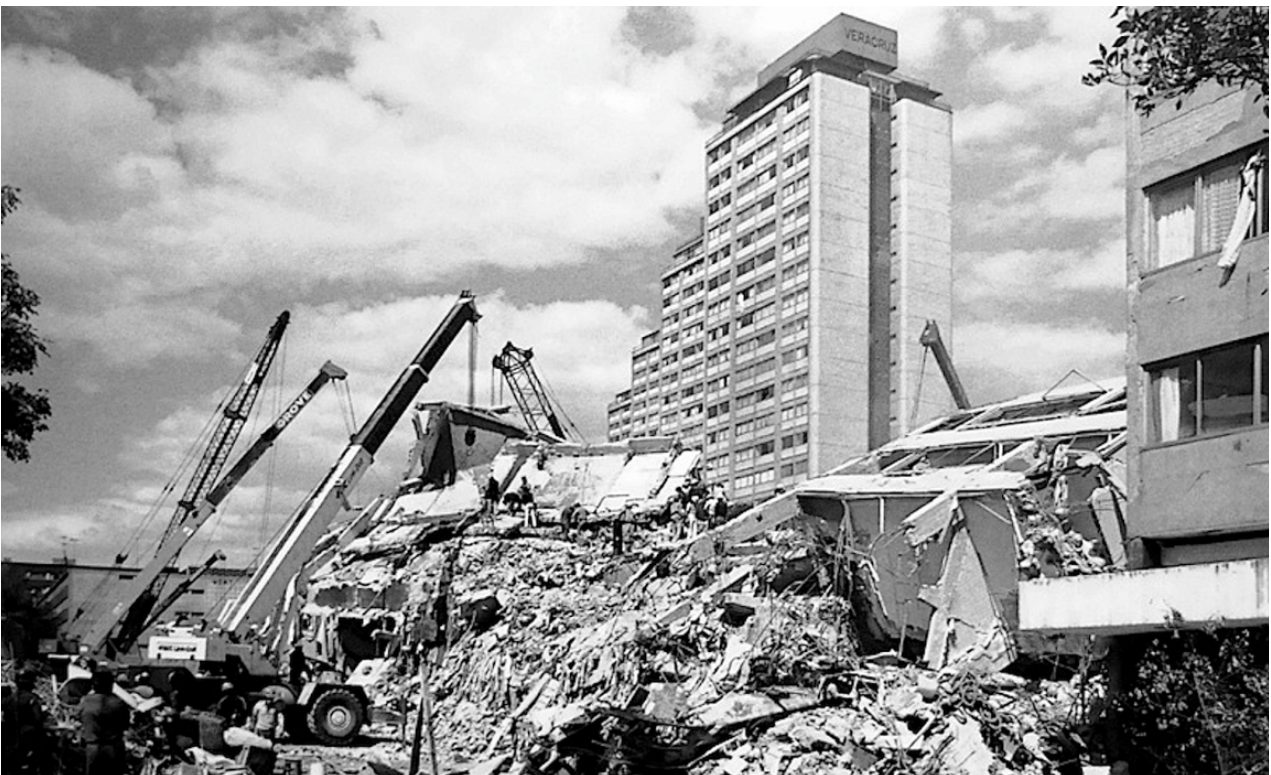
Imagen 108: Edificio de la U. H. Tlatelolco derribado por el sismo. Fuente: Forbes (s.f.).
