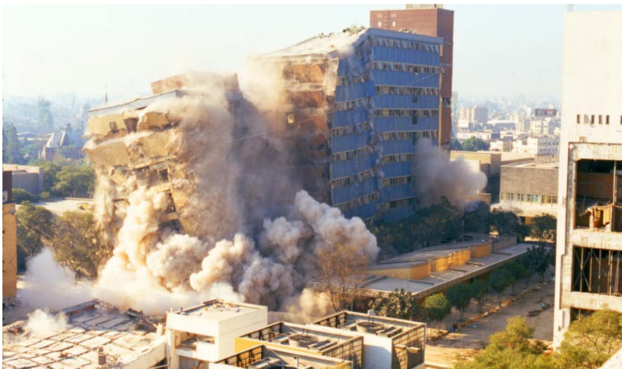
Imagen 130: Colapso de edificio dañado por sismo de 1985. Fuente: Fundación ICA 2020.
