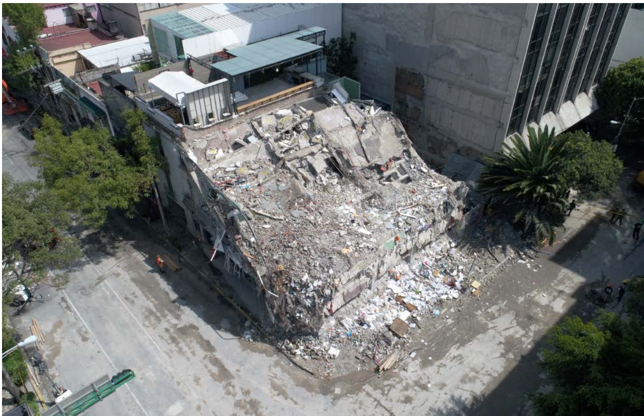
Imagen 141: Edificio colapsado con sistema de losa plana y columnas en esquina. Fuente: Santiago Arau, 2017.
