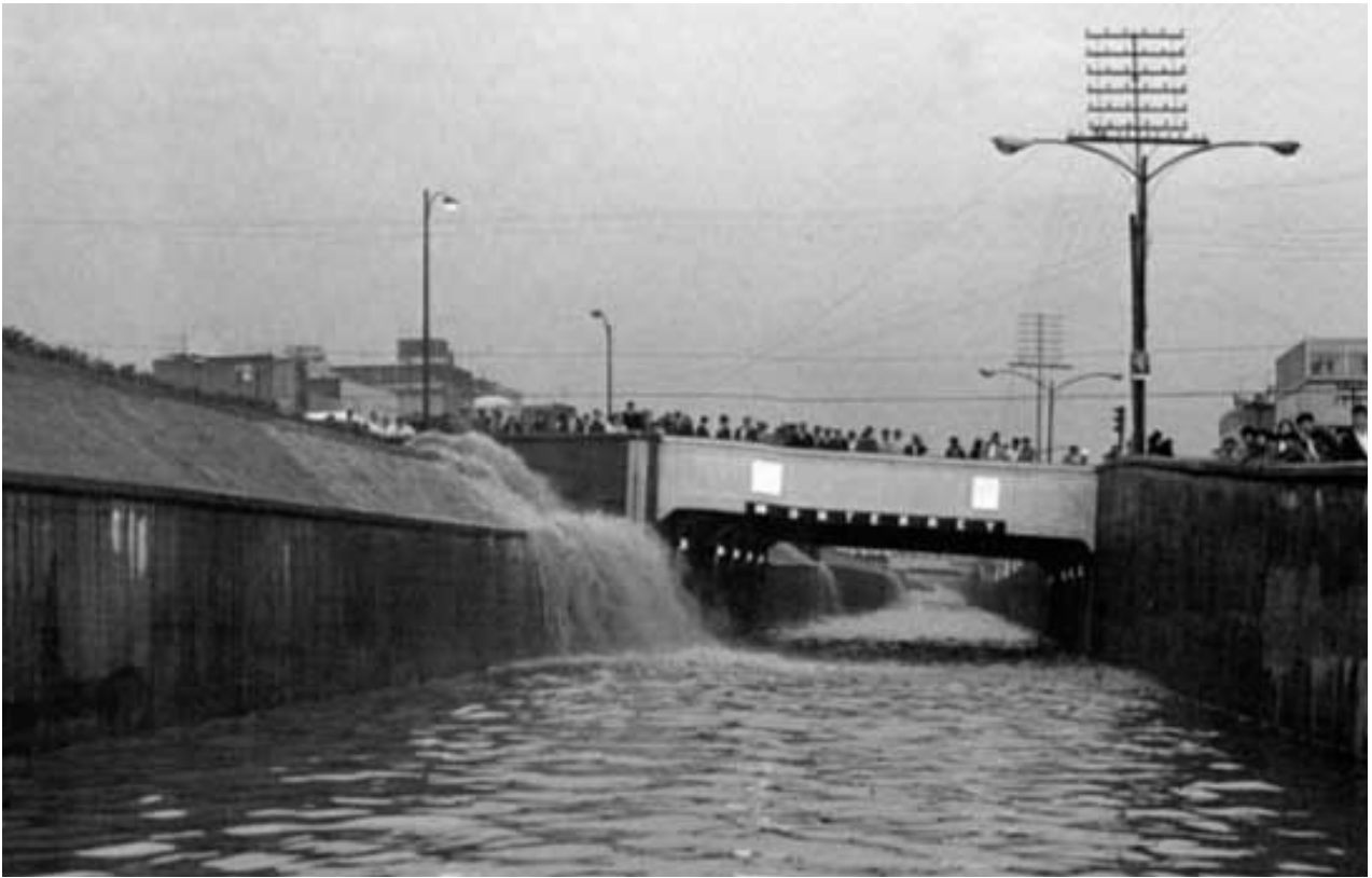
Imagen 164: Inundación en el Viaducto Miguel Alemán a la altura de la calle Monterrey, 1969. Fuente: Archivo Casasola 1969.
