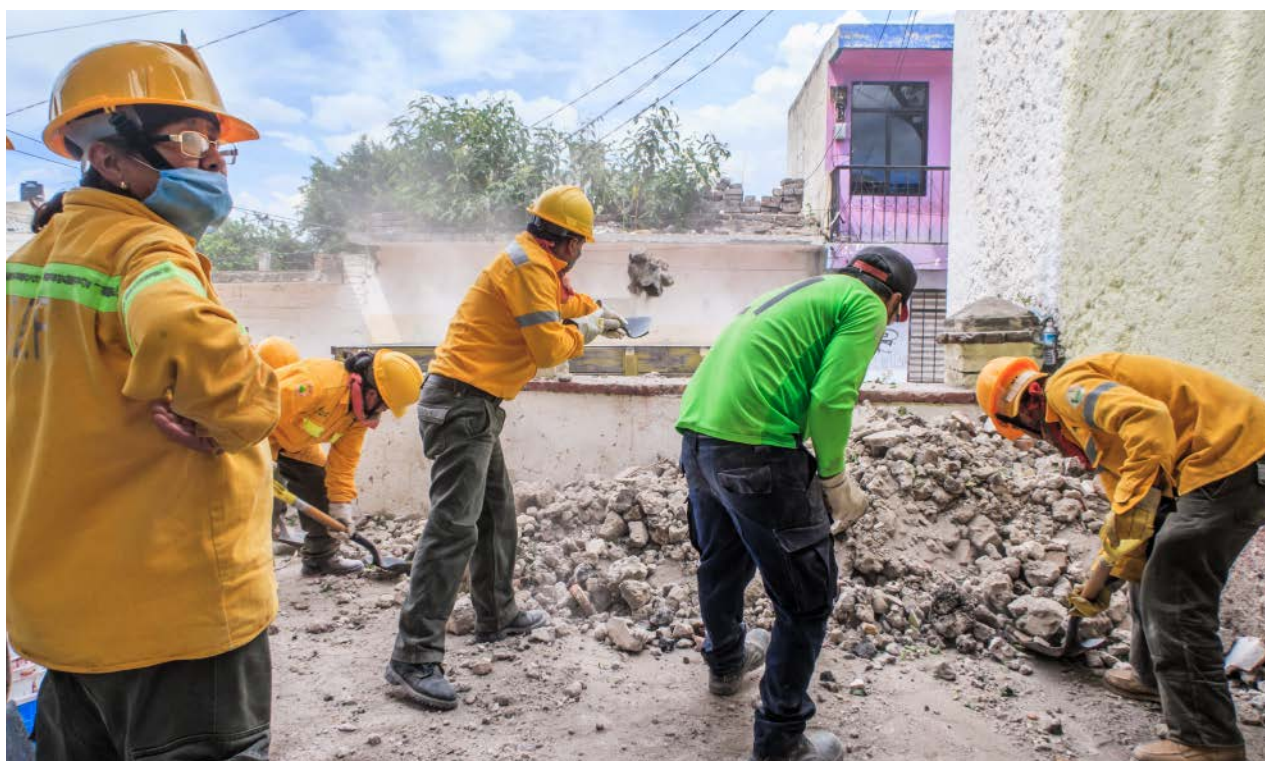
Imagen 8: Limpieza de escombros después del sismo de 2017. Fuente: Gobierno de la Ciudad de México 2017
