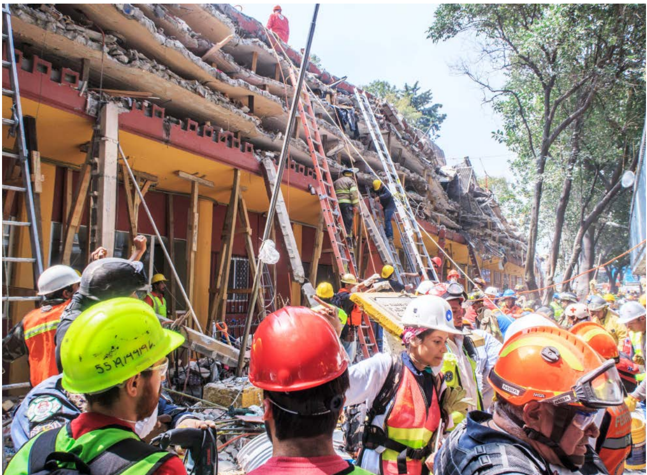
Imagen 144: Edificio colapsado. Fuente: Gobierno de la Ciudad de México, 2017.
