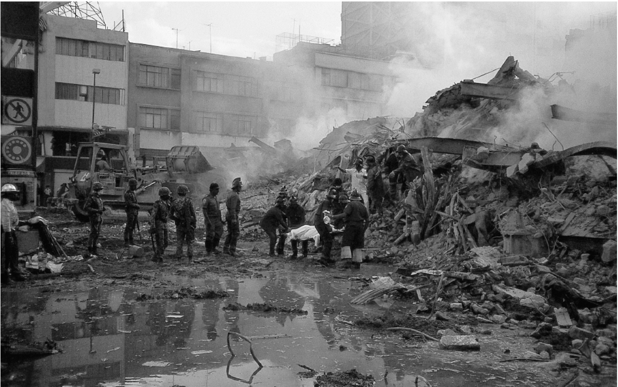
Imagen 107: Esfuerzos de rescate. Bomberos y ejército trabajando entre los escombros. Fuente: Fundación ICA 2020.
