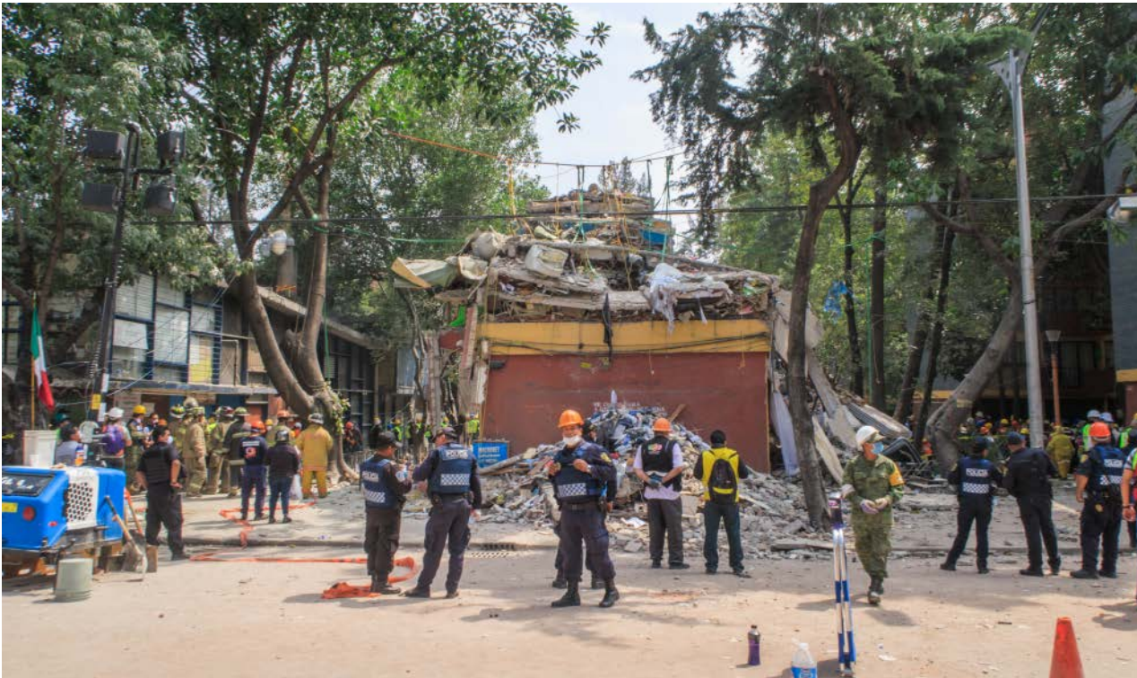
Imagen 9: Edificio colapsado después del sismo de 2017. Fuente: Gobierno de la Ciudad de México 2017
