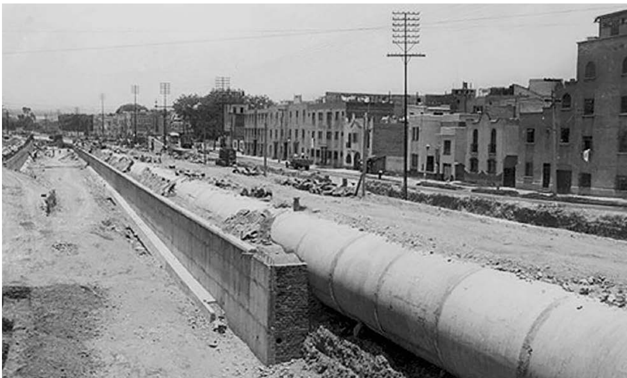
Imagen 74: Entubamiento del río de la Piedad para construir el primer Viaducto, 1949.
